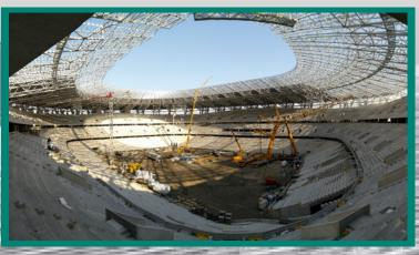
Lo stadio, completamente riscostruito e terminato nel novembre del 2019, vede l'installazione, nella parte di copertura traslucida, delle lastre corrugate in policarbonato compatto Macrolux Rooflite greca 315/56,8 nello spessore 2 mm prodotte da Stabilit
