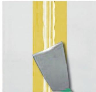
Führen Sie nach 4 oder 5 Minuten einen Spatel durch, um überschüssiges Dichtmittel zu entfernen.
