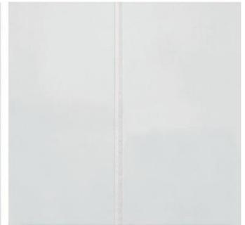
Entfernen Sie nach 1/2 Stunde das Klebeband, wobei Sie die Paneele und die Fuge unversiegelt zurücklassen.
